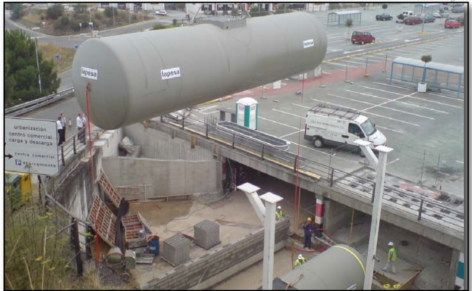
Descarga y colocación de depósitos de combustible en Ourense
