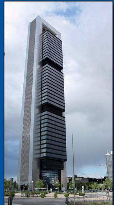
Su llamativo e innovador diseño tiene como característica principal la doble estructura que posee: una principal de hormigón armado que actúa a modo de bastidor soportando el peso del edificio y otra interior que soporta la fachada de cristal. Sus ascensores acristalados no desmerecen en absoluto protagonismo en la torre.
