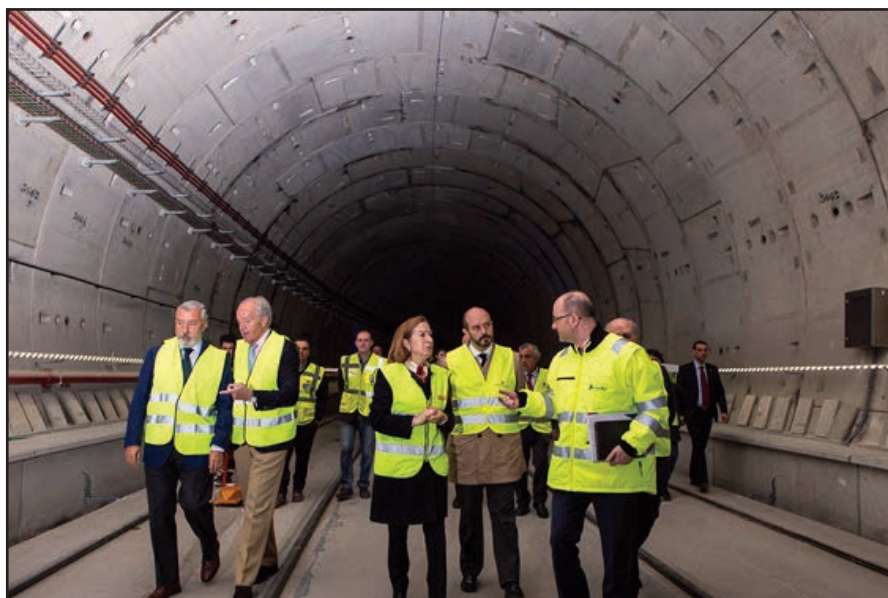
La ministra de Fomento, Ana Pastor, visitaba con Pedro Rollán, consejero de Transportes, Vivienda e Infraestructuras de la Comunidad de Madrid, las obras
